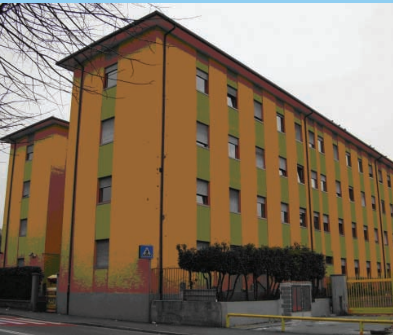
L'edificio del Nuovo Albergo Popolare in via Carnovali, 95 a Bergamo
